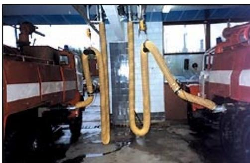
Система предназначена для транспортных средств, выхлопные трубы которых направлены вниз или в сторону.
